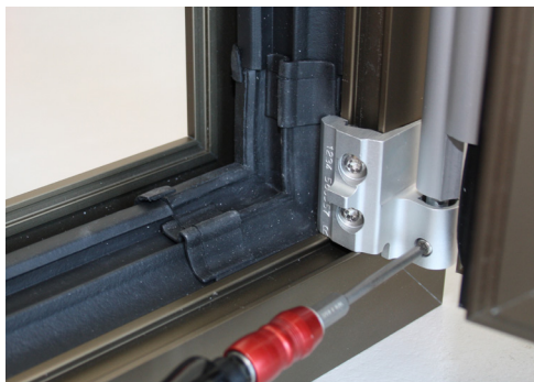
Sidojustering av nedre gångjärn.
