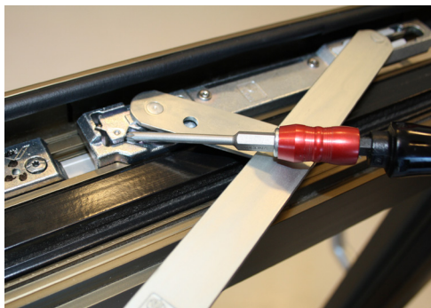
Sidojustering av övre gångjärn. Verktyg T8, T10 och T25.
