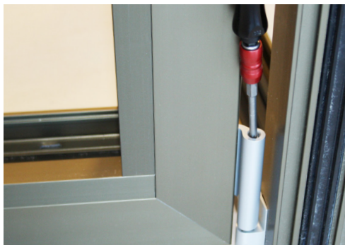
Höjjustering av nedre gångjärn.
