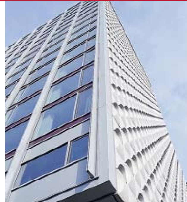
Hotel Mercure, Dresden Fassadensanierung WICTEC EL
